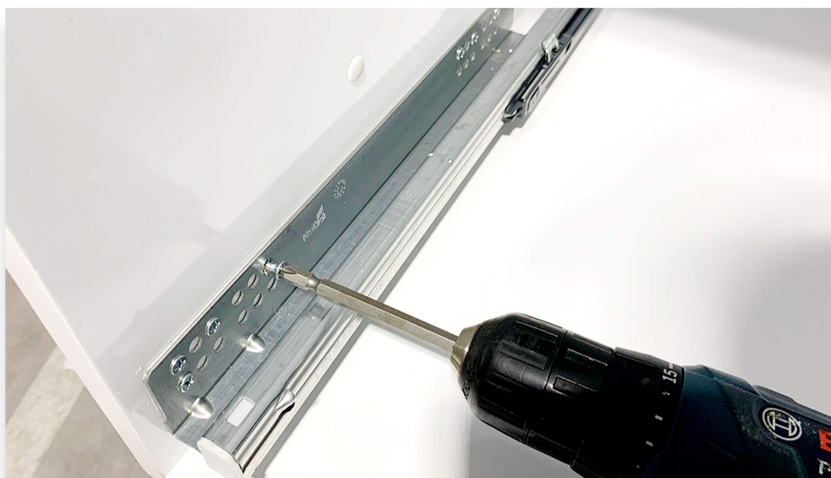
安装滑轨（左/右） 注：下层滑轨不是贴底安装
